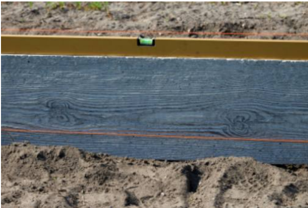
4. Zweite Lage aufsetzen
