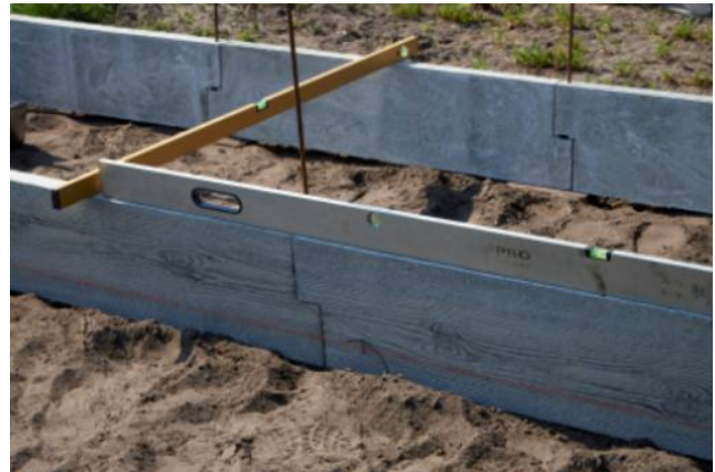
5. Flachstahl zwischen Elementen ohne Querwand einsetzen
