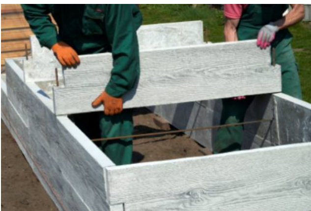
6. Querwände montieren
