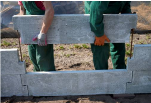
6. Querwände montieren
